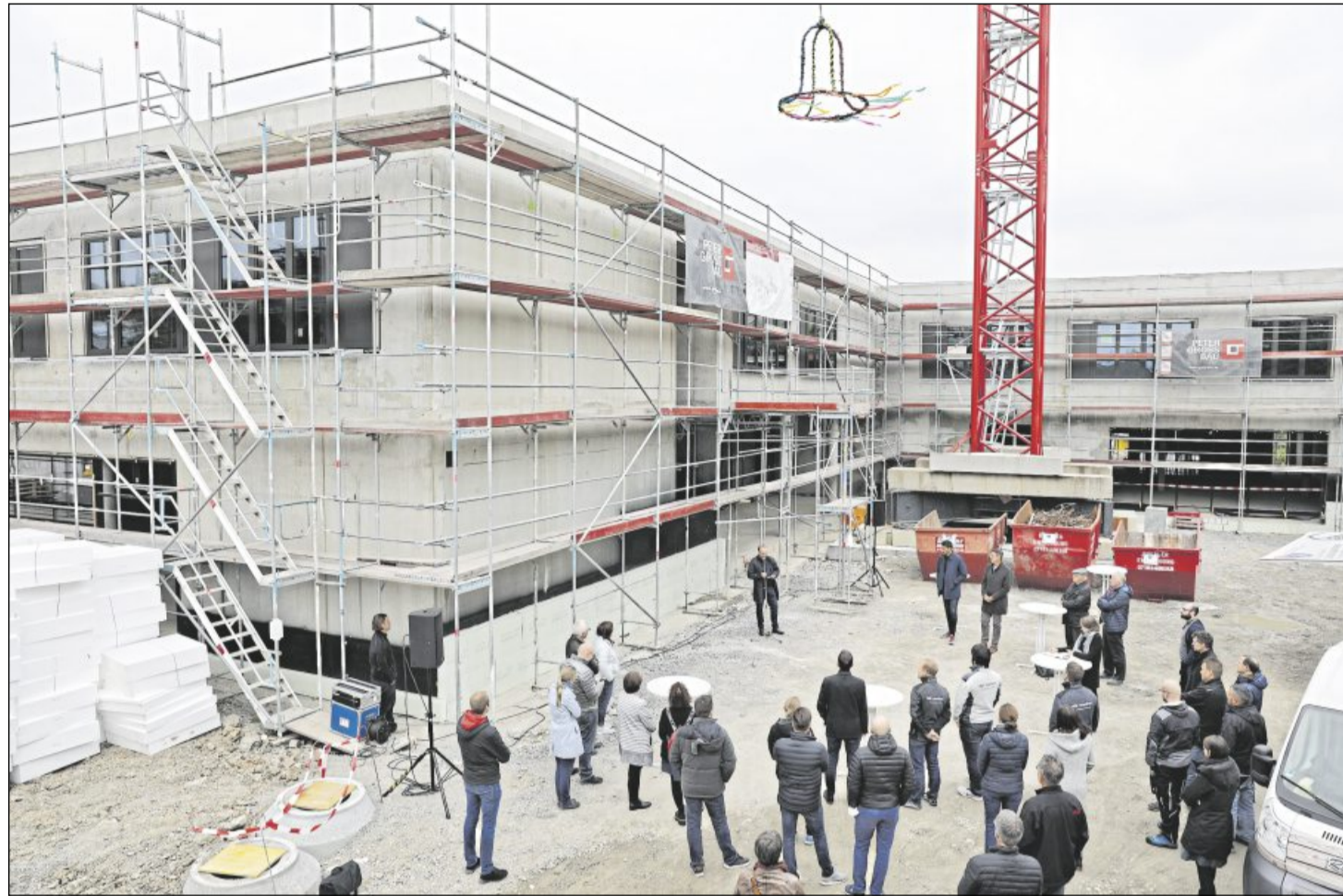
Eine typische Pflichtaufgabe: Der Bau der neuen, gut 15 Millionen Euro teuren Rainbrunnen-Grundschule.
